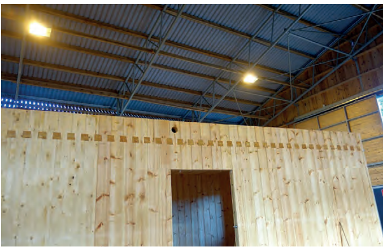
▲ Kun tarvittava korkeus, eli pituus on saavutettu, rakennelma käännetään kyljelleen ja saadaan aikaa pystyhirsimoduuli
