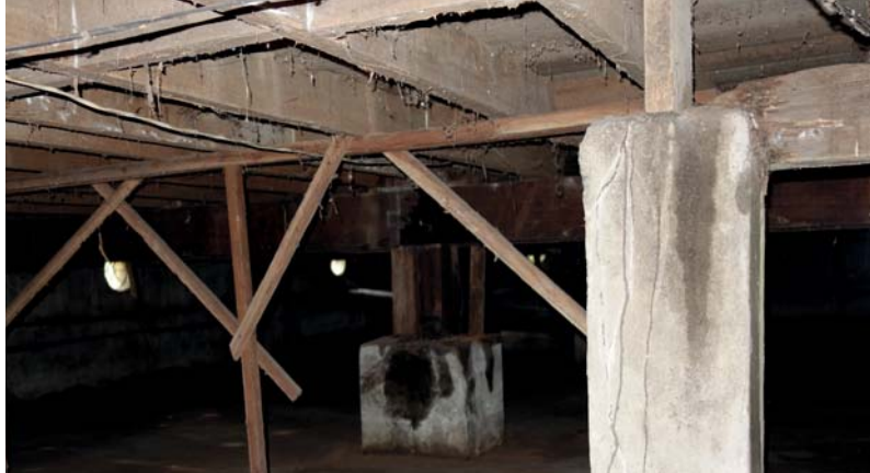
▲ Alapohjan tuuletus ja siinä käytetty erittäin kova ja termiiteille kelpaamaton puulaji, Balayong, selittävät rakenteen kestävyden.
